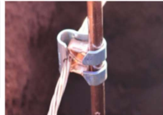
Conector a Compressão Cabo-Cabo
